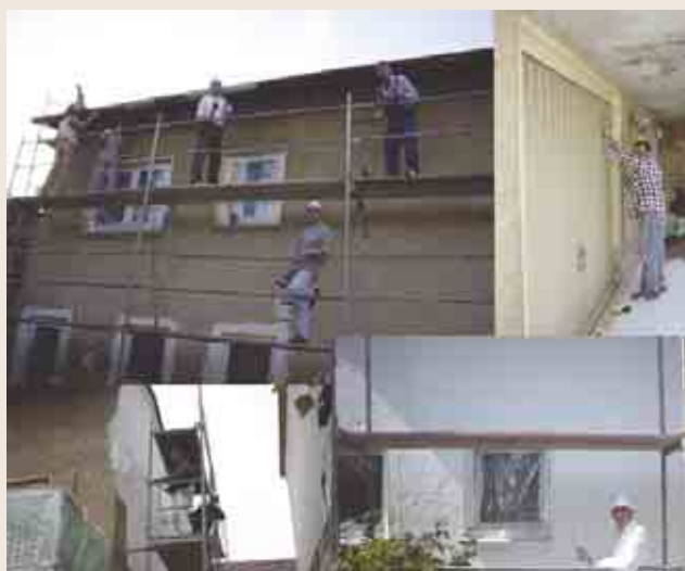
Neuer Fassadenanstrich der Gemeinde Flörsheim ...
